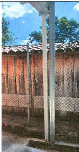
Foto1: Reparación de canales y bajadas de agua pluvial (elaboración de canaleta de piso con rejillas para corrimiento de agua pluvial)
