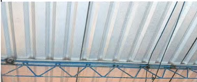
Foto 3: Reparación de estructura de techo
