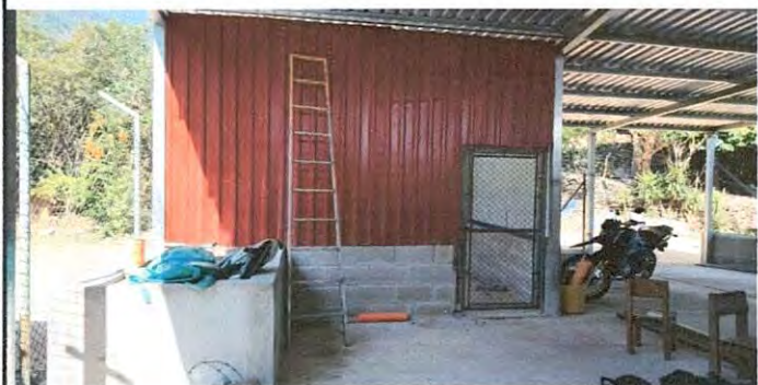
Foto 3: Reparación de cocina
