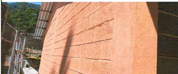
Foto 4: Pintura interior y exterior de instalaciones
